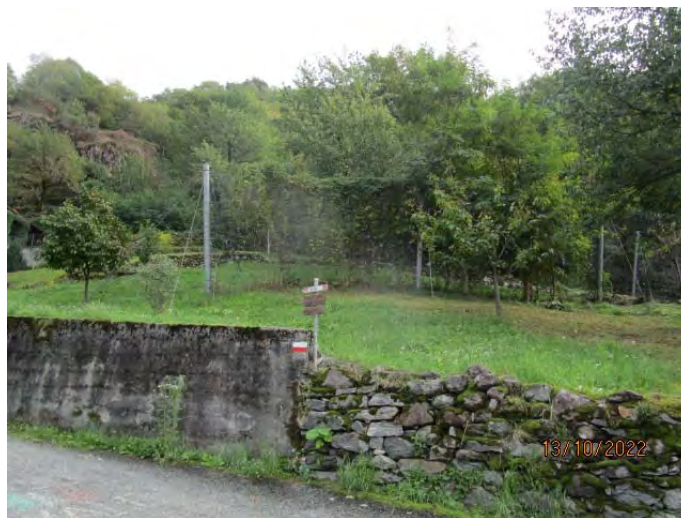
Opere di protezione del versante a monte dell'abitato di Verceia
